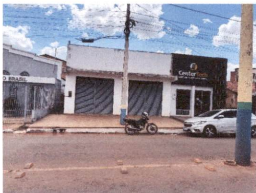
FOTO 01 – VISTA DA FACHADA
