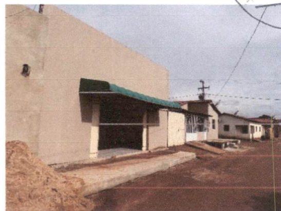
FOTO 02 – VISTA 2 DA RUA DE ACESSO AO IMÓVEL
