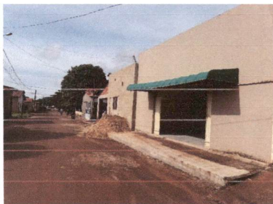
FOTO 01 – VISTA 1 DA RUA DE ACESSO AO IMÓVEL
