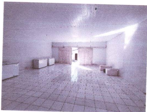
FOTO 07 - VISTA 2 INTERNA DO SALÃO
