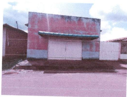
FOTO 03 - VISTA DA FACHADA
