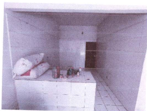
FOTO 05 – VISTA DA COZINHA
