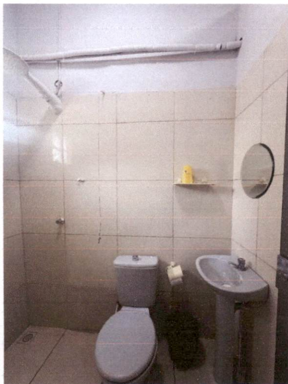
FOTO 29 - VISTA INTERNA 1 DO BWC 6
