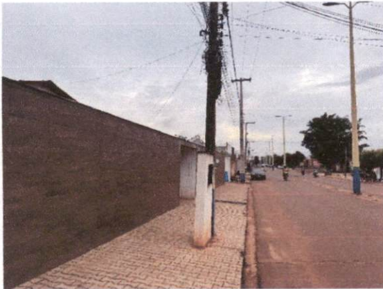
FOTO 01 – VISTA 1 DA RUA DE ACESSO AO IMÓVEL
