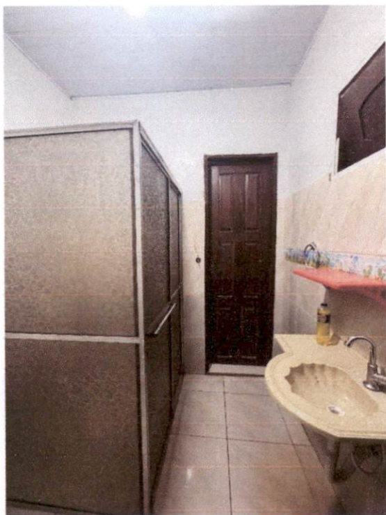
FOTO 15 - VISTA INTERNA 1 DO BWC 3
