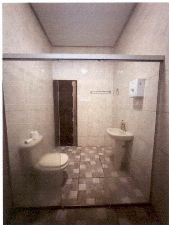
FOTO 11 - VISTA INTERNA 2 DO BWC 2
