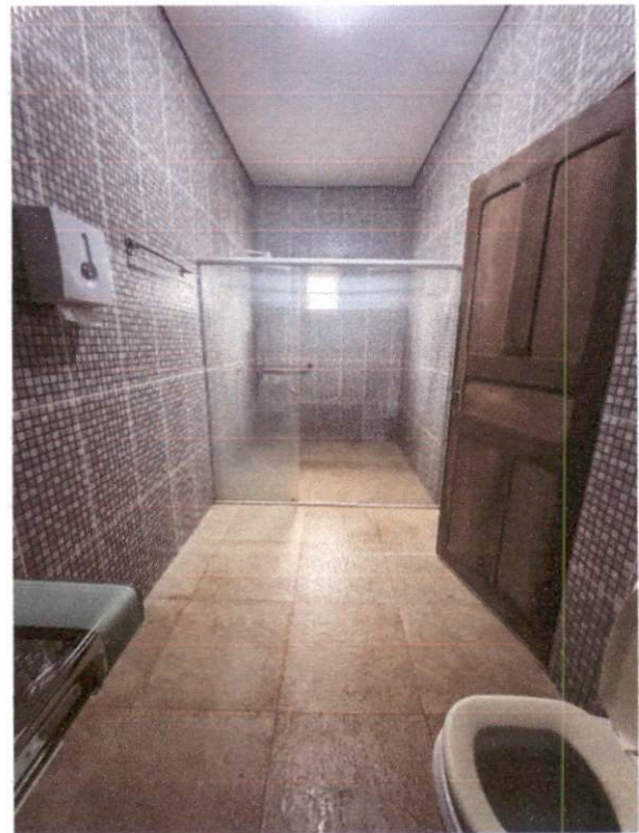
FOTO 08 – VISTA INTERNA 2 DO BWC 1
