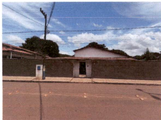
FOTO 09 - VISTA DA FACHADA
