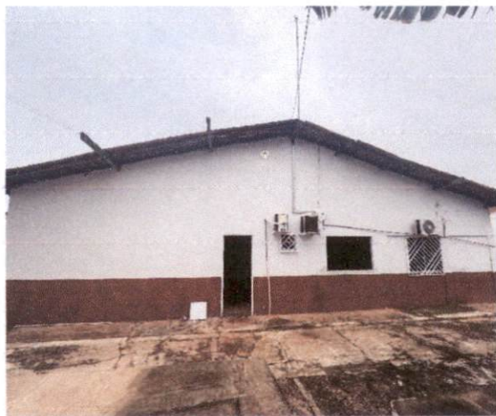
FOTO 31 - VISTA 2 DO CORREDOR
