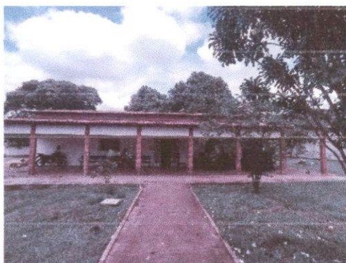
FOTO 03 – VISTA DA FACHADA
