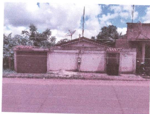
FOTO 03 – VISTA 1 DA FACHADA
