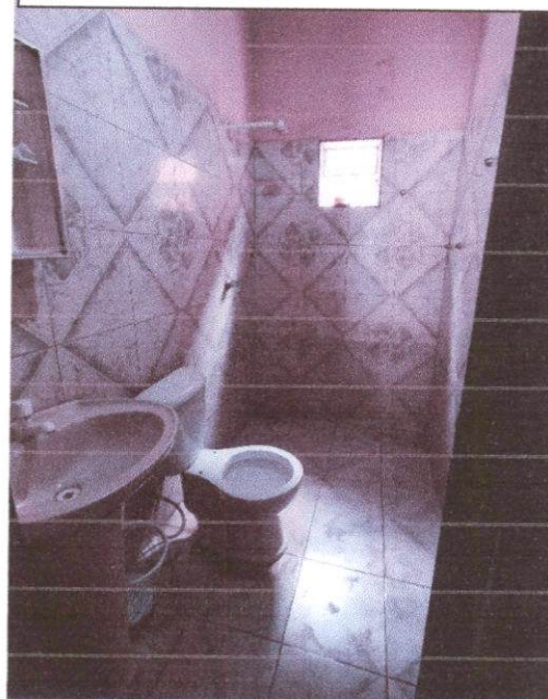
FOTO 08 – VISTA DO BANHEIRO
