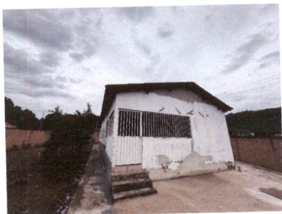
FOTO 05 – VISTA DA FACHADA POSTERIOR
