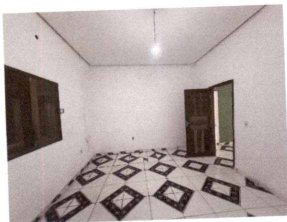
FOTO 15 - VISTA INTERNA 1 DO QUARTO 2
