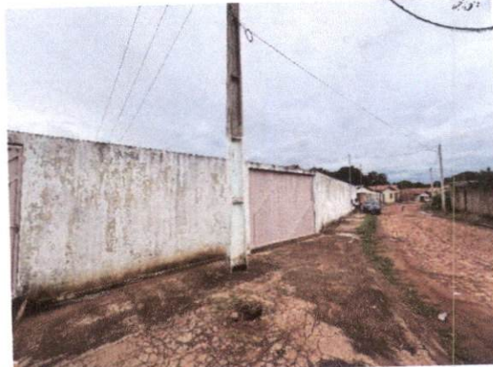
FOTO 02 – VISTA 2 DA RUA DE ACESSO AO IMÓVEL
