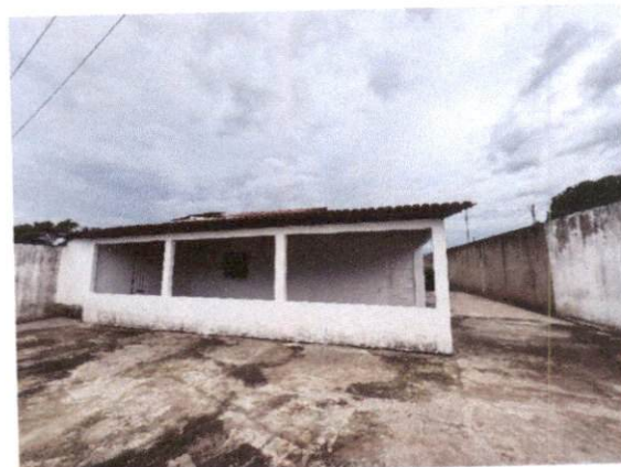
FOTO 04 – VISTA 1 DA GARAGEM
