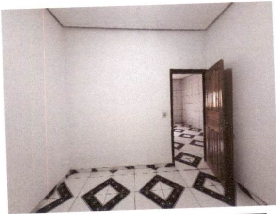
FOTO 21 - VISTA INTERNA 1 DO QUARTO 3
