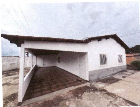
FOTO 03 - VISTA DA FACHADA FRONTAL
