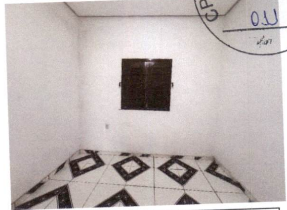
FOTO 22- VISTA INTERNA 2 DO QUARTO 3
