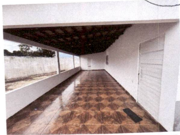
FOTO 08 – VISTA DA GARAGEM
