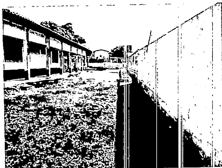
FOTO 8: VISTA LATERAL DO IMÓVEL.
