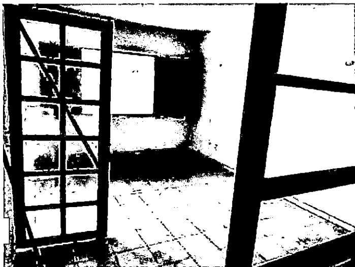
FOTO 17: VISTA INTERNA 11 DA SALA
