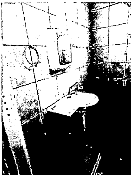
FOTO 9: VISTA INTERNA 5 DO BANHEIRO
