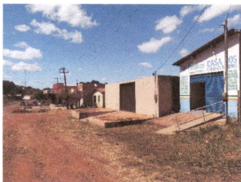
FOTO 03 - VISTA 2 DA RUA DE ACESSO AO IMÓVEL
