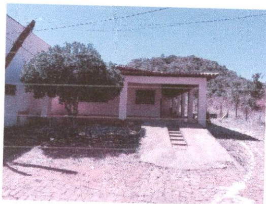
FOTO 03 – VISTA 1 DA FACHADA
