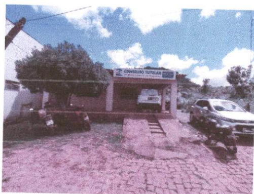
FOTO 05 – VISTA 2 DA FACHADA
