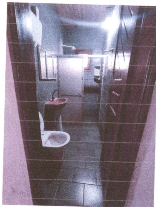
FOTO 08 – VISTA DO BANHEIRO
