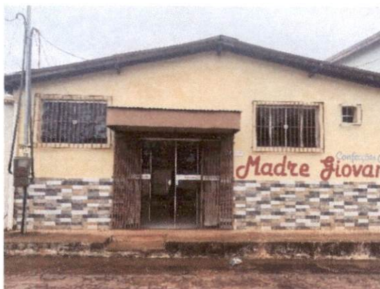
FOTO 01 – VISTA DA FACHADA
