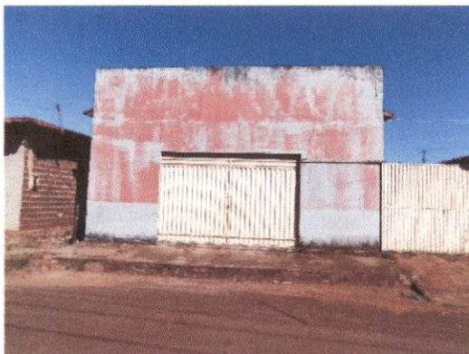
FOTO 03 - VISTA DA FACHADA
