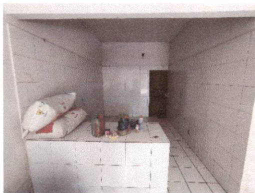
FOTO 05 – VISTA DA COZINHA
