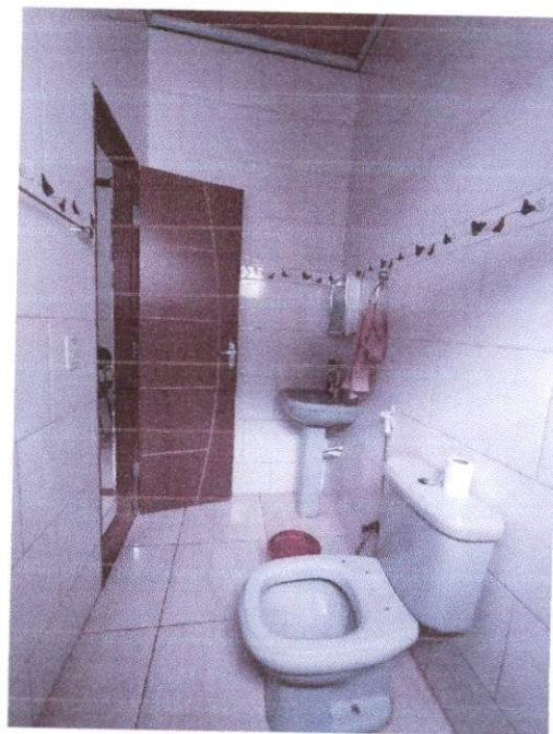
FOTO 10 - VISTA DO BANHEIRO
