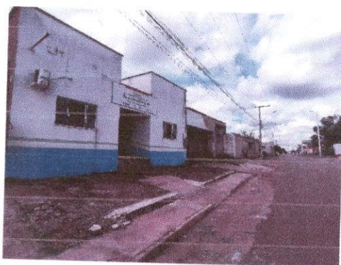
FOTO 01 – VISTA 1 DA RUA DE ACESSO AO IMÓVEL
