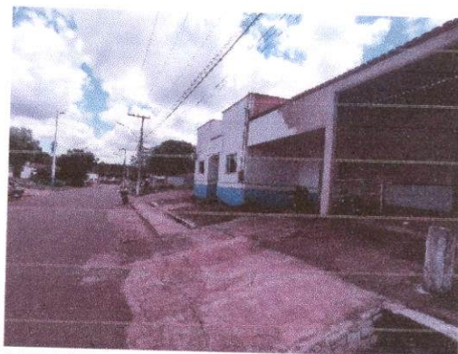
FOTO 02 – VISTA 2 DA RUA DE ACESSO AO IMÓVEL
