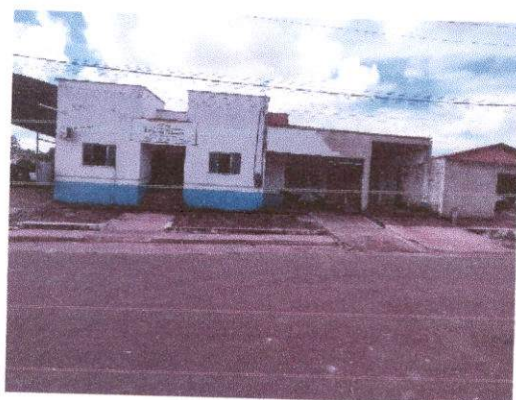
FOTO 03 – VISTA DA FACHADA
