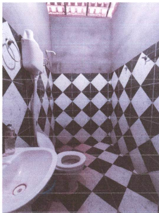
FOTO 06 – VISTA INTERNA DO BANHEIRO
