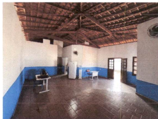
FOTO 06 - VISTA INTERNA 2 DA SALA
