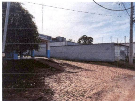
FOTO 02 – VISTA 2 DA RUA DE ACESSO AO IMÓVEL
