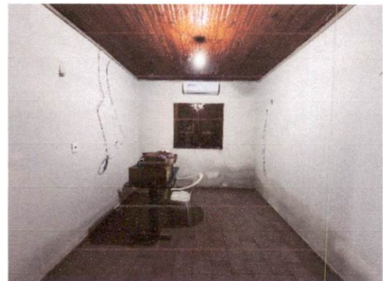
FOTO 10 - VISTA DO QUARTO 01
