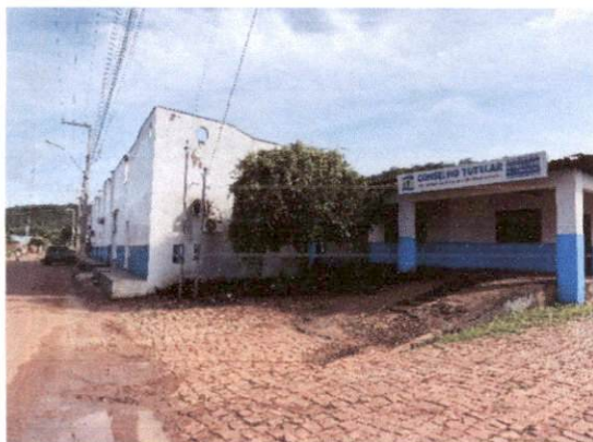
FOTO 01 – VISTA 1 DA RUA DE ACESSO AO IMÓVEL
