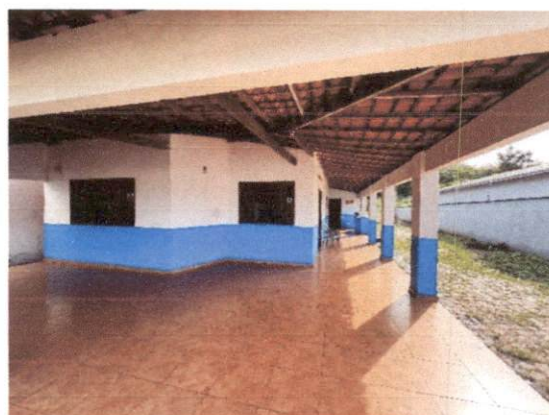
FOTO 04 – VISTA DA GARAGEM
