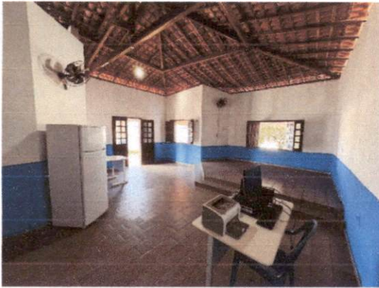
FOTO 07 - VISTA INTERNA 3 DA SALA
