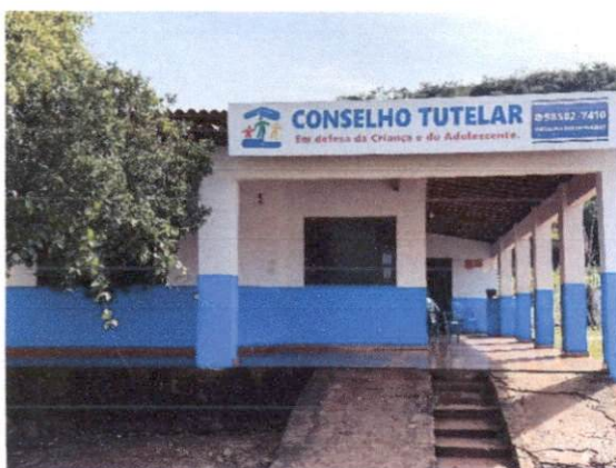
FOTO 03 - VISTA DA FACHADA
