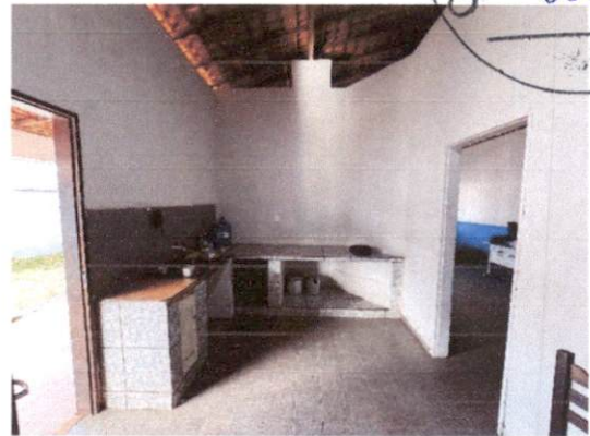
FOTO 08 – VISTA DA COZINHA
