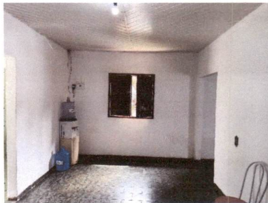
FOTO 06 - VISTA INTERNA 1 DA SALA 2
