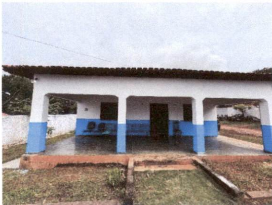
FOTO 03 - VISTA DA FACHADA FRONTAL
