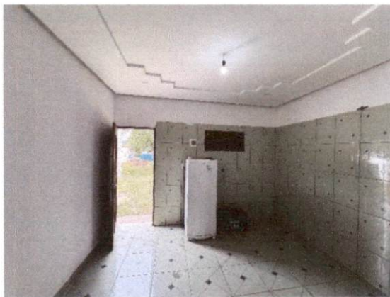
FOTO 09 – VISTA INTERNA 1 DA SALA 3
