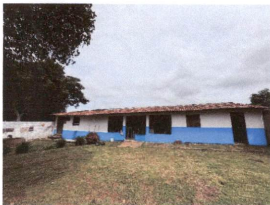
FOTO 17 - VISTA EXTERNA DA COZINHA
