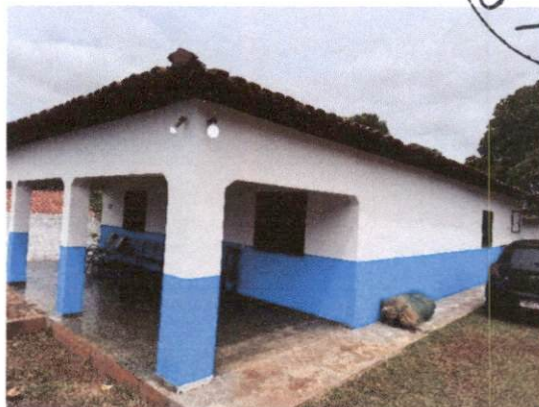
FOTO 18 – VISTA 2 DA FACHADA
