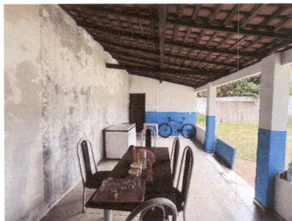
FOTO 16– VISTA INTERNA 2 DA COZINHA
