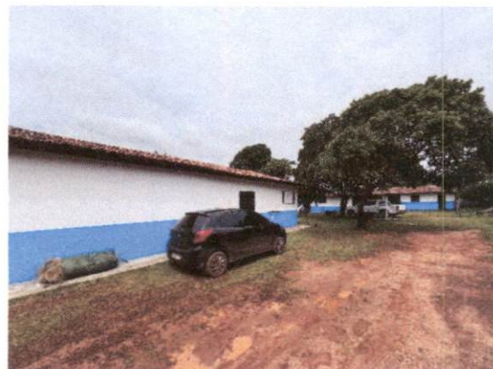
FOTO 20 – VISTA DA FACHADA LATERAL DIREITA
