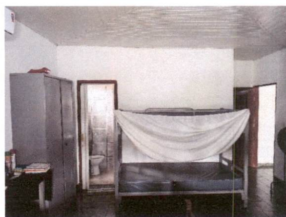
FOTO 12 – VISTA INTERNA 1 DO QUARTO 3
