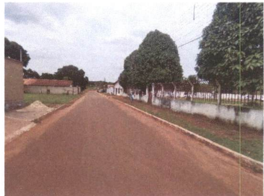
FOTO 02 – VISTA 2 DA RUA DE ACESSO AO IMÓVEL
