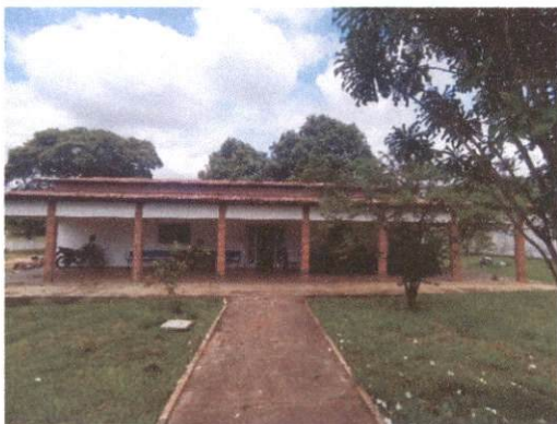
FOTO 03 – VISTA DA FACHADA
